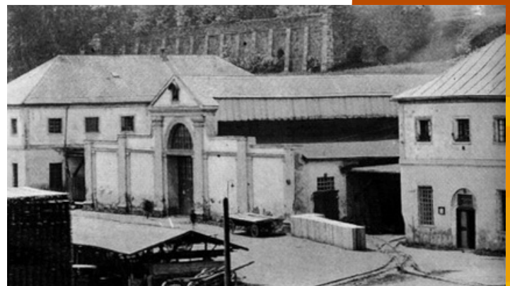
Der Dreiecksgiebel steht heute unter Denkmalschutz
